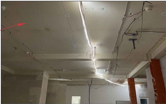
2 - Détail des plafonds du niveau 0, partiellement curés de leurs habillages
