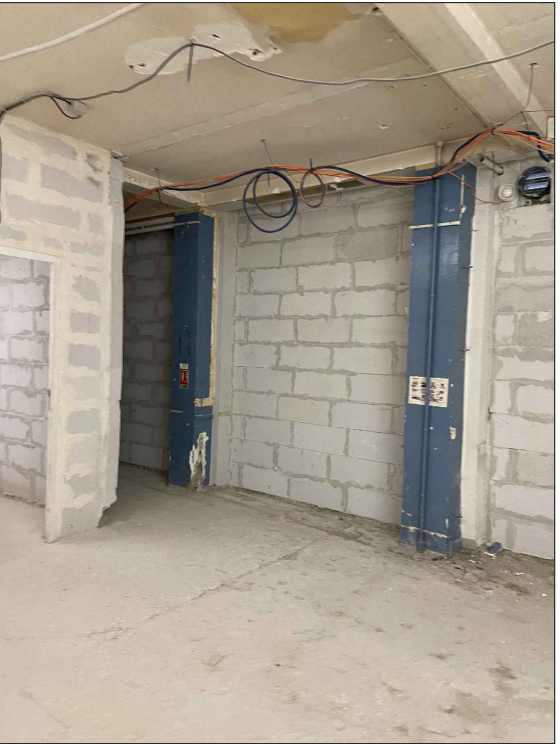
5 - Bouchements de baies provisoires en siporex à démolir, habillage des poteaux à curer
