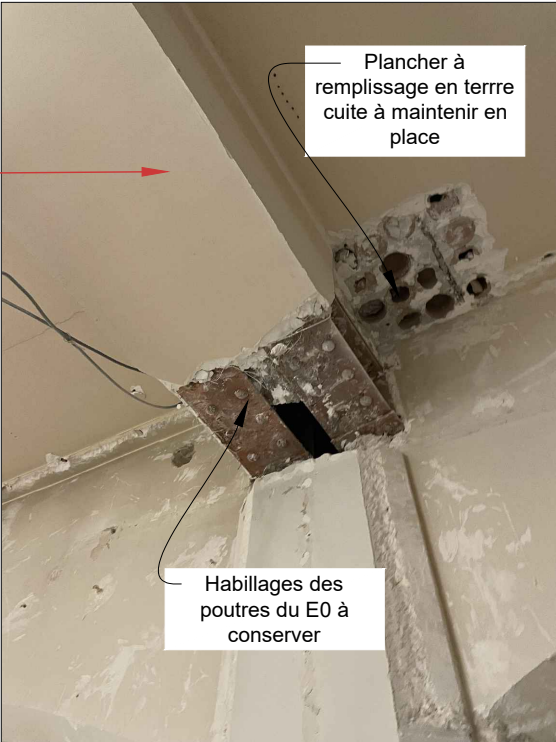
5 - Détail de la composition structurelle de la poutre longitudinale du plancher haut E0
