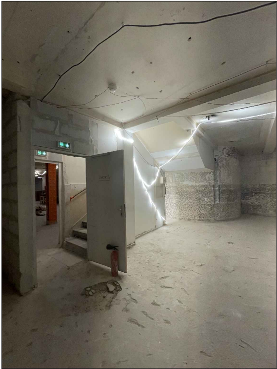
4 - Escalier béton menant au E0, ensemble escalier et cloisons siporex à démolir
