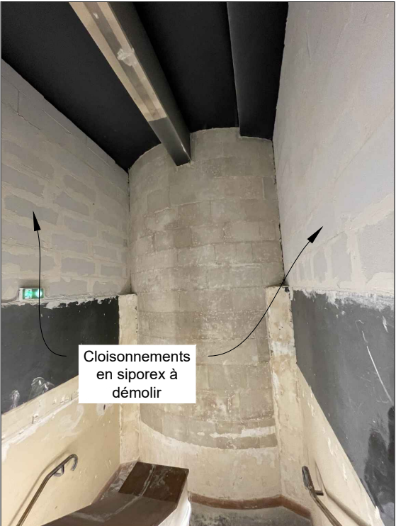
2 - Intérieur de la cage d'escalier à démolir, vue vers l'est
